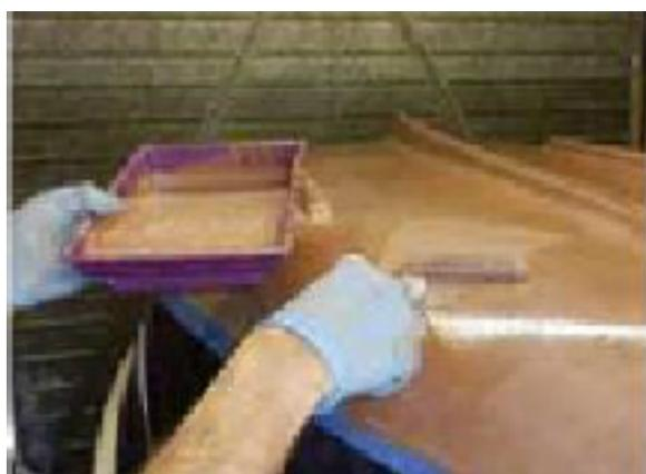
L'applicazione su una piccola imbarcazione è stato un modo prezioso per conoscere il prodotto e, anche se dopo soli sei mesi, ho potuto constatare il suo buon funzionamento nonché acquisire le piccole ma important tecniche di lavorazione. Sono ora più confidente e convinto di applicarlo su un'imbarcazione di maggiore dimensioni. Ne frattempo continuerò a monitorare il tender.
